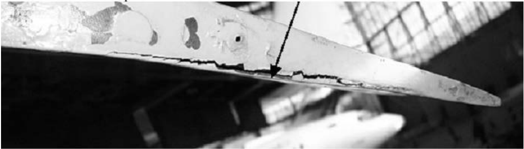
Рис. 3. Пример расслоения обшивки сотовой панели
