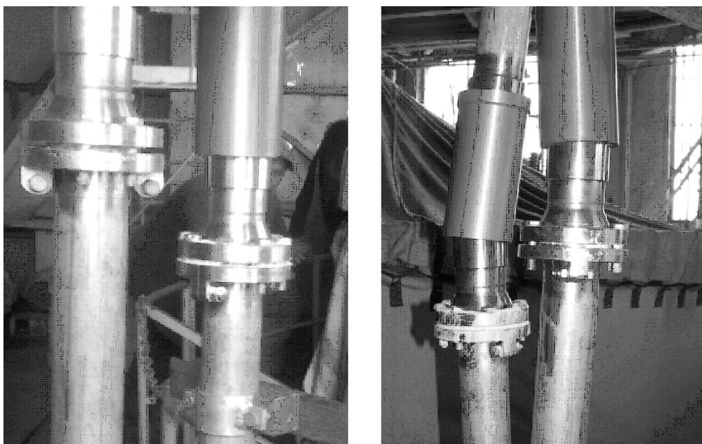
Рис. 3. Изображение трубопроводов (а – до гидроудара, б – после гидроудара)
