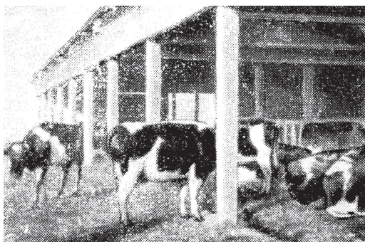
Рис. 4. Открытое помещение сборно-каркасной конструкции
