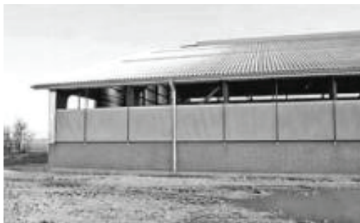
Рис. 7. Нижняя часть продольных стен для защиты коров от холодного ветра (глухая), высотой не менее 1,2 м
