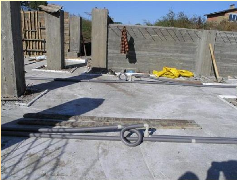
Рис.4 Сезонний ґрунтовий акумулятор тепла
