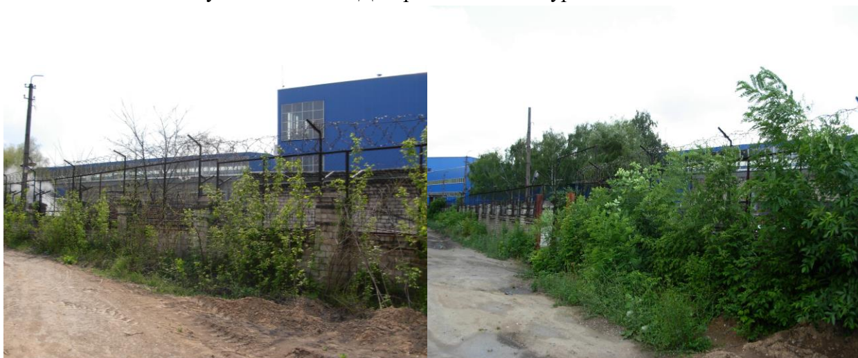
ПД 20 – штучне насадження ясеня ланцетолістого ( СГ_1 ) на відстані 50 м від ВАТ «Дніпрошина».
