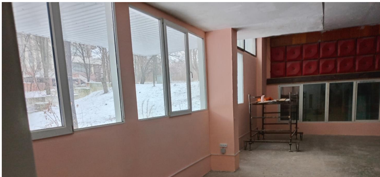
Фото 3 Завершено роботи з утеплення стін та проведено електромережу
