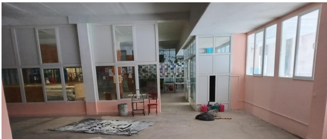
Фото 2 Замінена перегородка для облаштування тренажерного простору
