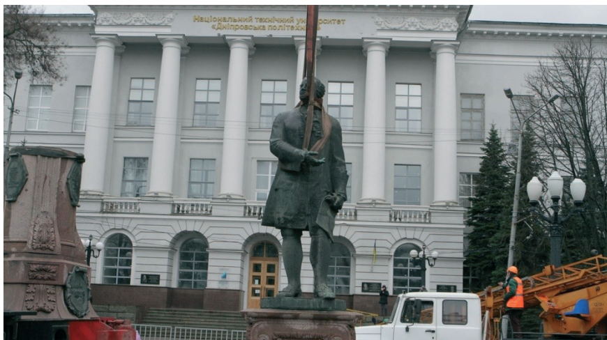
Демонтаж пам'ятник М. Ломоносову в м. Дніпро, 6 січня 2023 р.
