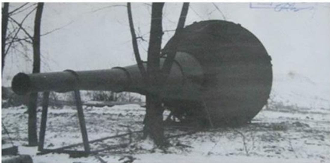
**Рис.7. Внешний вид катеноидального рупора.**
